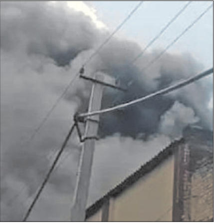
पानीपत। कूरियर कंपनी के भवन उड़ता धुआं। रखा था, जिसने पल भर में आग पकड़ ली। दूसरी ओर, दमकल के अधिकारी आग लगने के कारणों व हुए नुकसान का आकलन कर रहे हैं।
